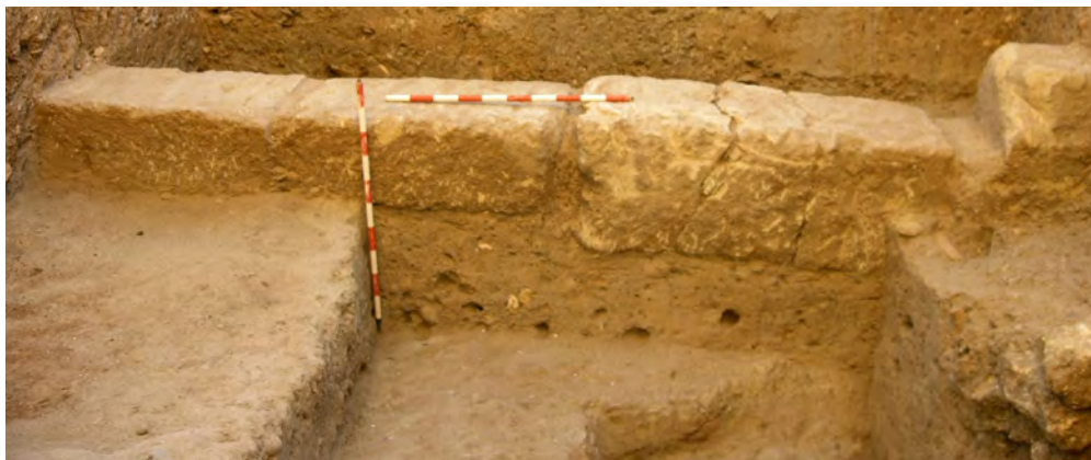
Fig. 6. Av. Ronda de Isasa, 4: fracturas y buzamiento en la cimentación de un paramento (García y Osuna, 2005: lám. 25).
